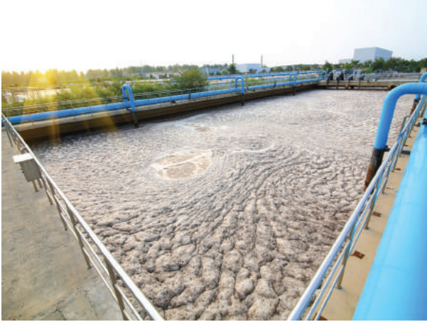
가장 기본적인 하수처리는 미생물이 공기를 이용하여 유기물을 분해하는 것이다. 사진에서 하수처리과정 중 미생물이 하수를 처리할 수 있도록 공기를 넣어주는 것을 볼 수 있다.
