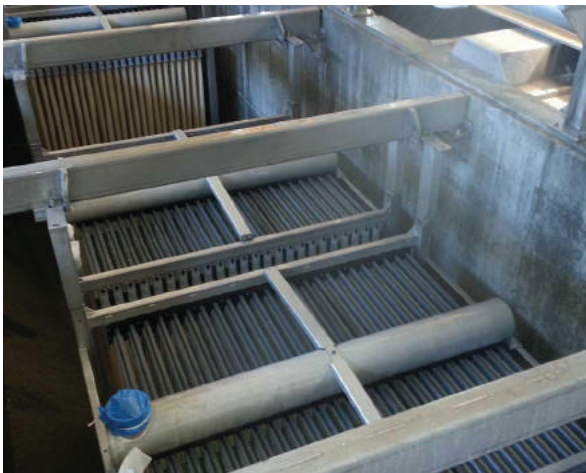
분리막 생물반응조 설치 모습. 비교적 좁은 공간에서도 고효율 하수 처리가 가능해 지역 단위의 소규모 하수처리 시스템에 주로 활용된다. © LEOPOLD
