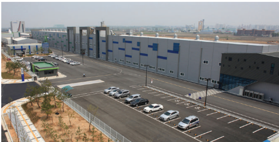
한국은 탄소소재 분야의 상업화가 다소 늦은 편이다. 다행히 최근 들어 대기업들이 관련 시장에 주목하고 본격적인 양산 준비를 갖추면서 탄소소재 분야의 발전이 기대된다. 탄소소재는 관련 기술이 아직 개발중이라 성장가능성이 큰 분야다. 사진은 효성이 전주에 준공한 탄소섬유 공장, 연산 2,000톤 규모다. © 효성
