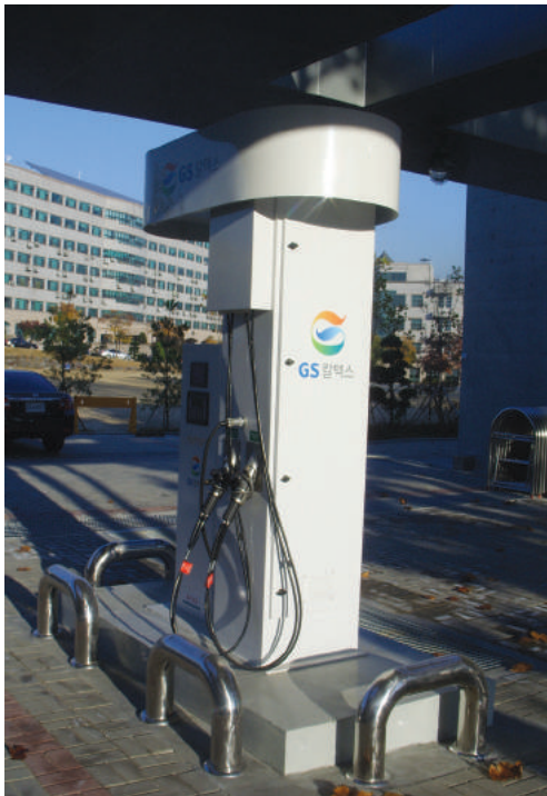
GS칼텍스에서 설치한 수소연료전지자동차용 수소 충전소. 수소연료전지자동차의 성패는 자동차 자체의 성능보다 수소연료 공급망을 얼마나 확충하느냐에 달려 있다. 현재도 자동차 연료가 유류와 LPG로 사실상 이원화돼 있어 새로운 연료 도입이 가능하긴 하지만 편리하게 사용할 수 있을 만큼 많은 수의 충전소를 확보하기는 쉽지 않다. 전기차 역시 동일한 문제를 안고 있다. © 서울시
